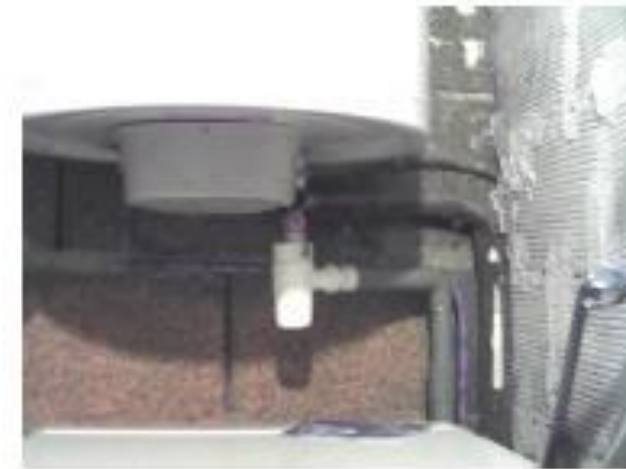
Tuyau de départ d'eau chaude non isolé
